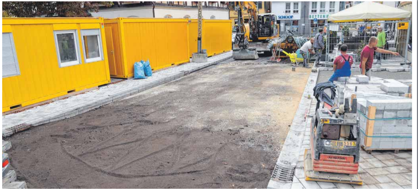
Der provisorisch vor Schützen verlegte Asphaltbelag wurde hier entfernt. Anschließend wurde ein neues Pflaster verlegt. FOTO: ARCHIV
